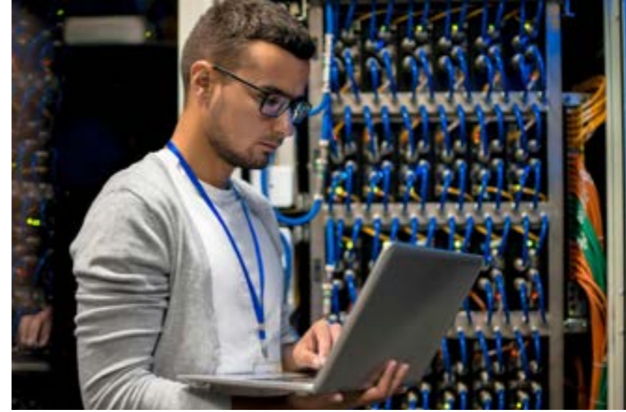
Technicien réseau à l'hôpital
