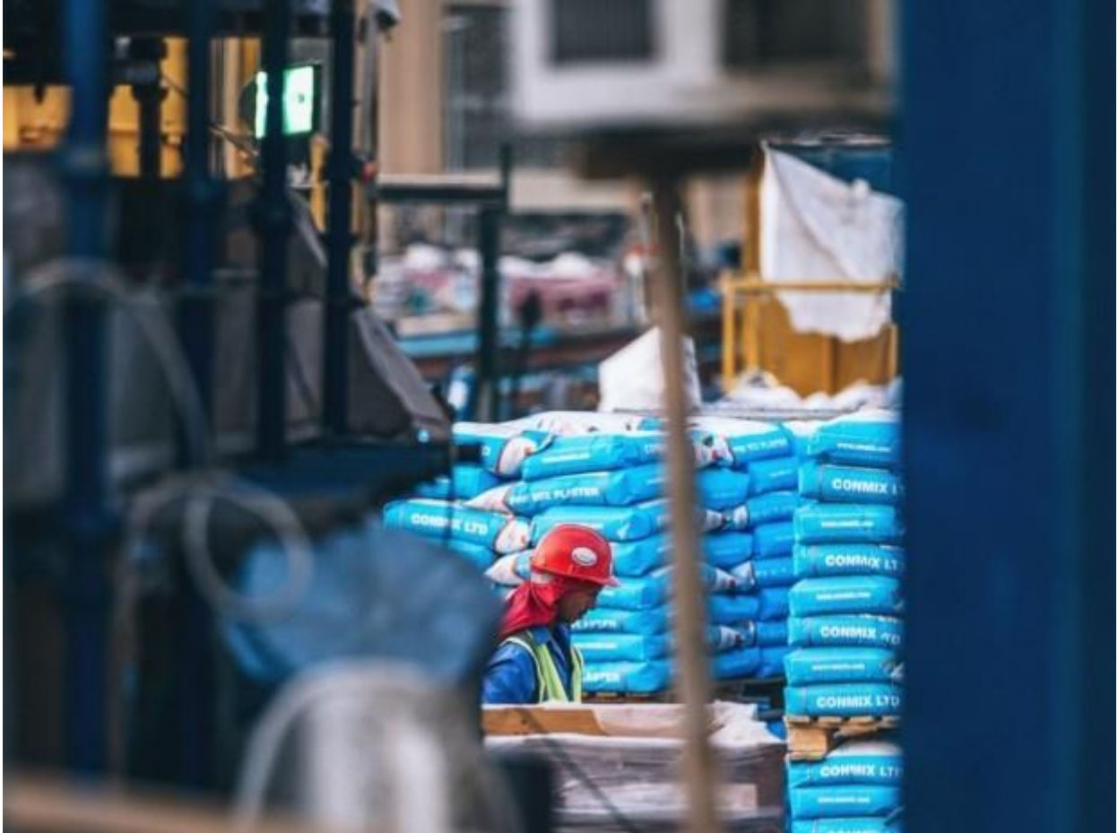
Compagnon chantier travail détaché © Pixabay
